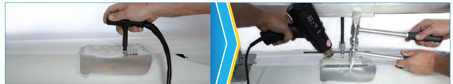
Stud Welding (Alumet)
